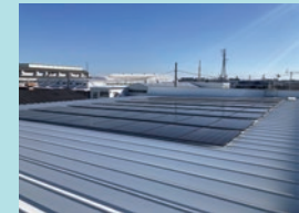
太陽光パネルを 事務厚生棟屋根に設置
