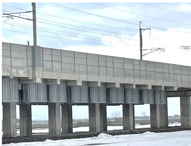
試験設置された吸音板
