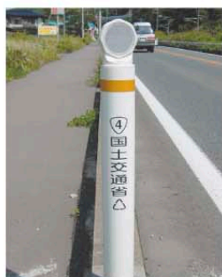
支柱にジスロンパイプを使用
