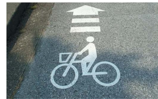
加熱貼付のシートタイプでスピーディー・簡単に施工可能。文字・マーク標示・補修などの小規模なライン施工に最適です。自転車レーン用のデザインも多数ご用意しています。
