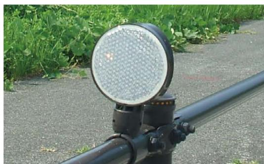
車道の側方に沿って道路線形などをわかりやすくし、運転者の視線誘導を行う交通安全施設です。視程不良時にも自動車のヘッドライトを反射し、路側や道路線形の視認性を高めます。
