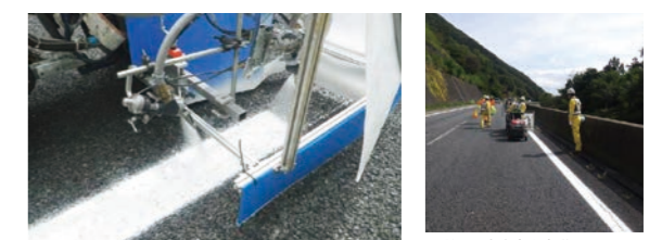
長寿命によるメンテナンス回数削減 長寿命型 路面標示材「ロードライン K1E-9」 従来品耐久年数 約1~3年 ➡ 塗料耐久年数 約10年
