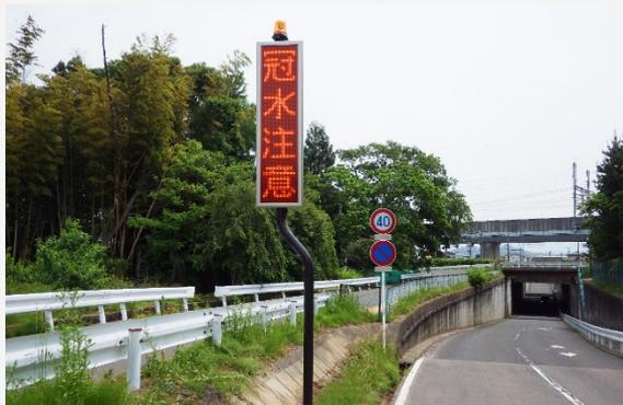
遠隔操作対応 LED 電光表示板 IOT タイプ
