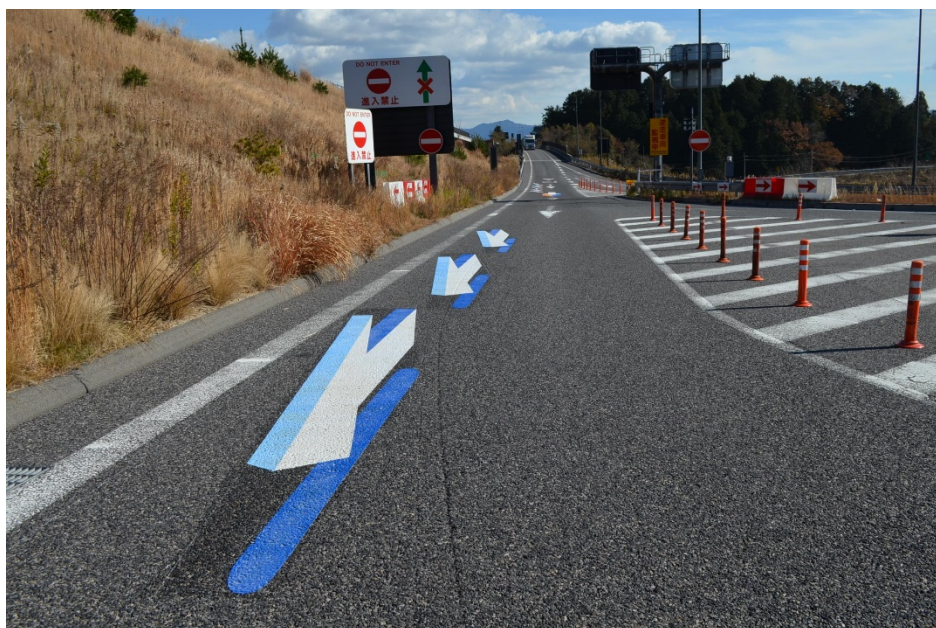
新名神高速道路 甲南 PA の逆走防止表示
