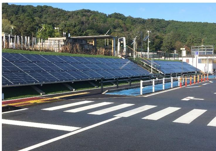
道夢道内の法面に太陽光発電パネルを設置。発電した電力により、道夢道内の全電力消費をまかなうとともに、余剰分は滋賀工場の生産活動に活用します。
