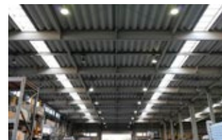
照明設備のLED化
