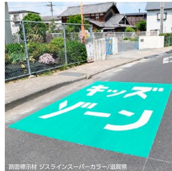
路面標示材 ジスラインスーパーカラー/滋賀県
