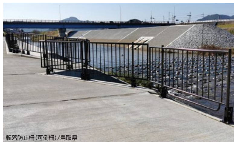
転落防止柵(可倒柵)/鳥取県
