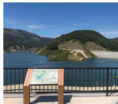
福岡県那珂川市「五ヶ山ダム」
