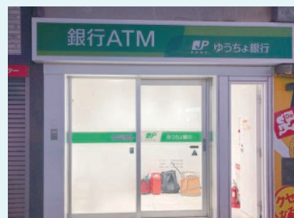
店舗サイン(上部の内照式サインやガラス貼りサイン)…前面板はアクリル板に透過シート貼り付けた仕様で夜間は内部のLEDが発光し視認性を高めます
