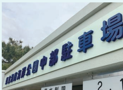
カルプ文字…カルプボード(発泡ウレタン樹脂材)をカットして作る立体的な文字
