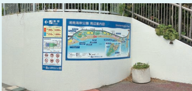
壁面取付サイン…R形状の壁面に対し、アルミ板を使用した壁面サインを取り付けています
