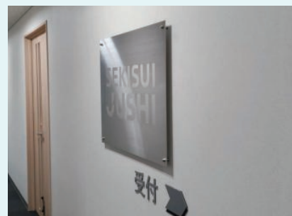
SUS銘板…ステンレス素材の銘板。下地はヘアライン仕上加工(屋内)
