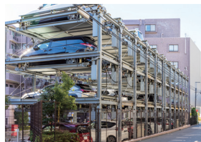
機械式駐車場まわり
