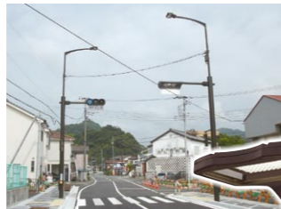
灯具のLED省電力化 道路灯、街路灯
