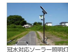
冠水対応ソーラー照明灯
