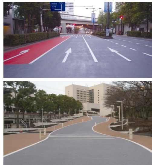
路面温度上昇の原因となる近赤外線を反射させる遮熱性顔料を含む遮熱舗装です。(日本ライナー(株))
