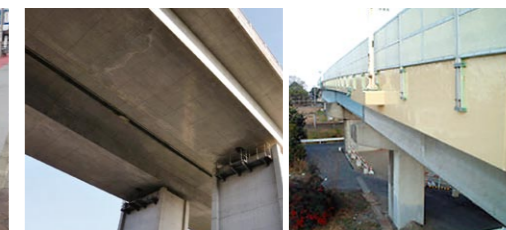
既設高架部の安全を確保し、施設利用の長寿命化を行う補修工法で、廃棄物低減、無駄な工事の低減によるCO2削減に貢献します。
