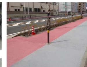
近赤外線を効率的に反射することで、路面の蓄熱を抑え、路面温度の上昇を抑制します。
