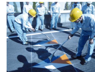
施工現場実習の様子
