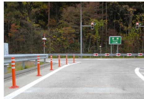
ドライバーが誤進入するおそれのある危険箇所に、車線分離標「ポールコーン」を設置することで、逆走の物理的な抑止を図ります。「ポールコーン」は特殊ウレタン樹脂の弾性体で車両が接触してもすみやかに復元します。
