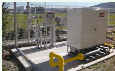
天然ガス受入設備(整圧機)
