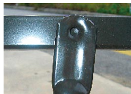
パネル部材の無溶接化(リベット取付)
