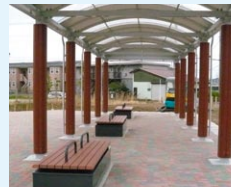
防災ベンチ+防災シェルター
