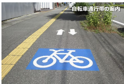
工場一体化された象嵌シートは、プライマー塗布なしで簡単に施工できます。
