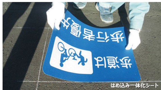
工場一体化された象嵌シートは、プライマー塗布なしで簡単に施工できます。
