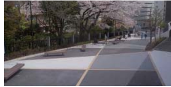
遮熱性舗装工事 (日本ライナー(株))
