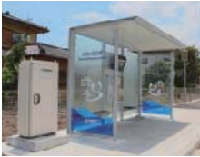
BRT シェルター「UBR」 ソーラー照明灯
