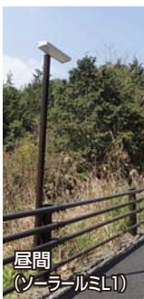
避難路の夜間の安全対策として照明を設置する整備において、小型ソーラー照明灯「ソーラールミL1」が活用されています。既存の防護柵の支柱に後付け可能で、配線不要の太陽電池式照明灯です。
