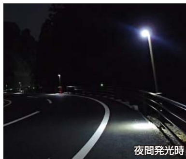
避難路の夜間の安全対策として照明を設置する整備において、小型ソーラー照明灯「ソーラールミL1」が活用されています。既存の防護柵の支柱に後付け可能で、配線不要の太陽電池式照明灯です。
