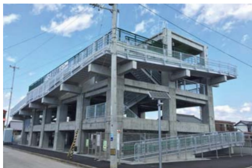
巨大津波から住民を守るために整備が進められている津波避難タワーの通路に、当社の防護柵が活用されています。
