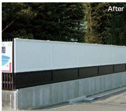
ブロック塀を撤去してめかくし塀を設置することで生活道路、通学路の安全対策となります。
