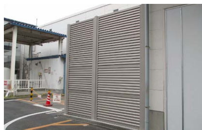
通風タイプにより騒音対策を図りながら通気が可能
