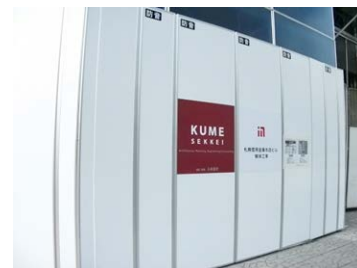
工事中の騒音対策として、仮囲いに防音機能を持たせたパネル形状の仮設材です。
