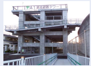
津波避難タワー
