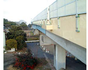
コンクリートはく落防止工事 (日本ライナー株式会社)
