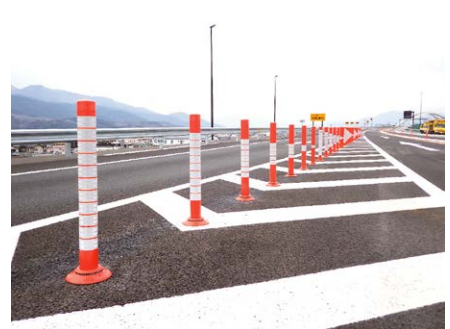
ドライバーが誤進入するおそれのある危険箇所に、車線分離標「ボールコーン」を設置することで、逆走の物理的な抑止を図ります。「ボールコーン」は特殊ウレタン樹脂の弾性体で車両が接触してもすみやかに復元します。
