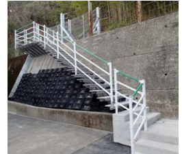
コンクリート壁後付け 階段システム
