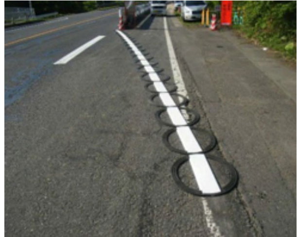
登坂車線内での活用
