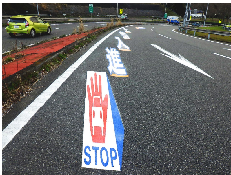
東名高速道路 横浜町田 IC の逆走防止標示（道路進行反対側から撮影）
