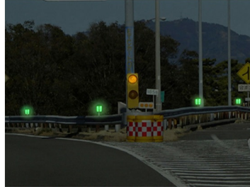
千鳥発光で分岐点を明示化（分流部）
