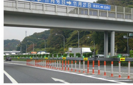
流れ発光で通行方向認識（合流部）
