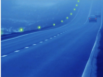
同時発光で線形を明示化（霧発生時）
