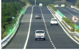
流れ発光で走行速度認識（サグ部）
