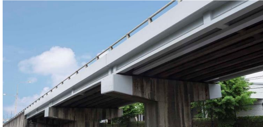
コンクリート片剥落防止システム / 埼玉県
