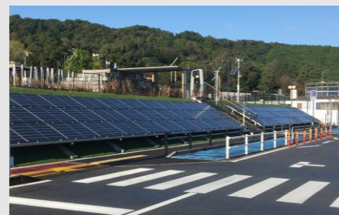
道夢道設置 太陽光発電システム
