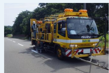
ロードラインマーキュリードライサポート工法施工
