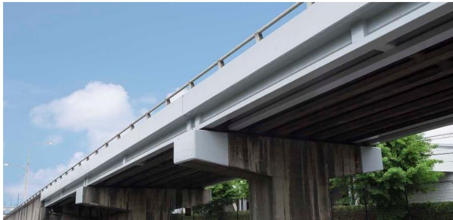
コンクリート片剥落防止システム / 埼玉県
