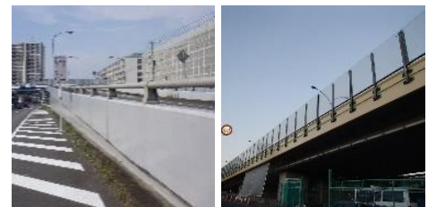
コンクリート剥落防止工法 QR工法
