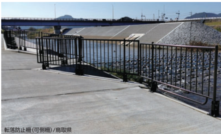
可倒式構造によりパネルを水平にする事が可能です。
