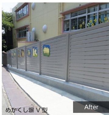
めかくし塀 V 型 保育所や小学校外周のブロック塀を撤去してめかくし塀を設置することが進められています。
