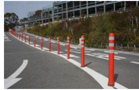
車線分離標「ポールコーン」
