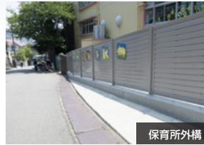
めかくし塀「V型」 保育所外構
