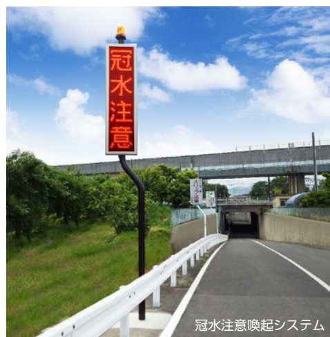
アンダーパス内の冠水状況を静電容量式センサで検知して、電光表示板の表示内容を切り替えます。 ①「走行注意」 ⇒ ②「冠水注意」 ⇒ ③「通行止」
