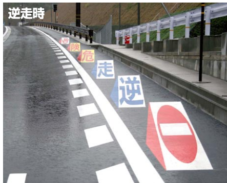
立体的に見える標示材である「ソリッドシート(イメージハンブ)」を用いて、視覚効果により「逆走危険」をドライバーに注意喚起します。
