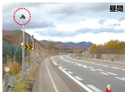
LEDと特殊オリジナルレンズを組み合わせ、带状の発光ラインを路面に照射し、外側線の位置を明示
