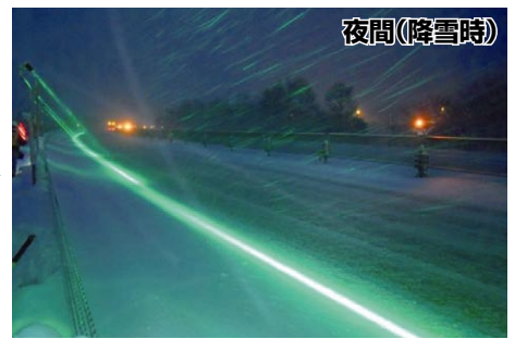
LEDと特殊オリジナルレンズを組み合わせ、带状の発光ラインを路面に照射し、外側線の位置を明示
