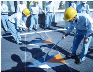
施工現場実習の様子
