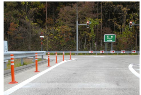
ドライバーが誤進入するおそれのある危険箇所に、車線分離標「ボールコーン」を設置することで、逆走の物理的な抑止を図ります。「ボールコーン」は特殊ウレタン樹脂の弾性体で車両が接触してもすみやかに復元します。
