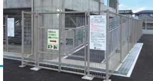
非常時 進入門扉
