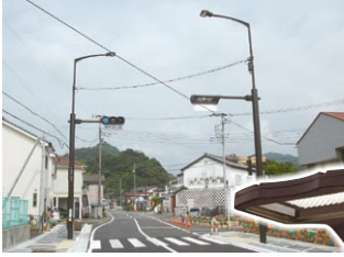
灯具のLED省電力化 道路灯、街路灯
