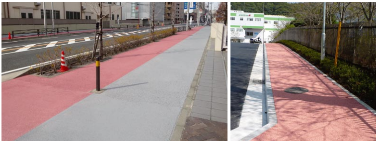
近赤外線を効率的に反射することで、路面の蓄熱を抑え、路面温度の上昇を抑制します。(日本ライナー(株))
