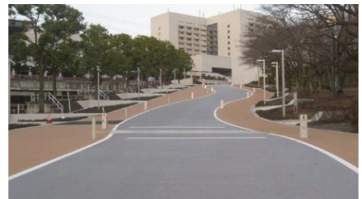
路面温度上昇の原因となる近赤外線を反射させる遮熱性顔料を含む遮熱舗装です。(日本ライナー(株))
