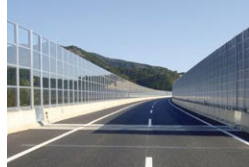
統一型防音壁+透明板
