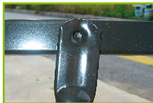
パネル部材の無溶接化
