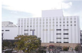
ビル外装パネル
