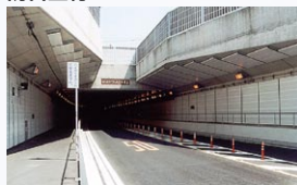
トンネル吸音内装板
