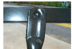
パネル部材の無溶接化(リベット取付)
