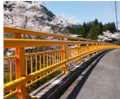
補修高欄 ビューレイルマックス
