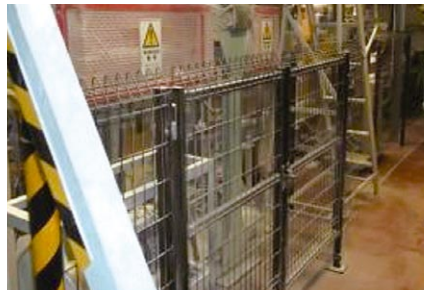
設備安全対策強化(安全柵設置)
