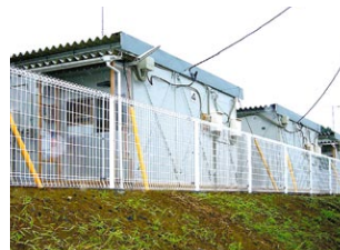
仮設住宅の外構として使用された「メッシュフェンス」
