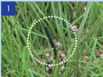
1 Viuノズルを人工芝の隙間に一定間隔で設置
