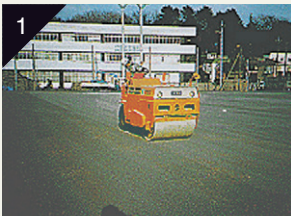
1 アスファルト舗装 不陸検査後に引渡しを受ける
