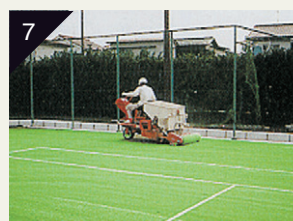
7 砂の撒布 専用砂撒布機で砂の撒布
