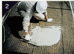
2 不陸修正 特殊修正材で不陸調整
