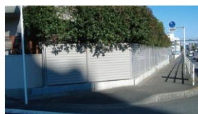
改修後 めかくし塀V型 H1500
