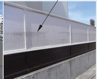
宮城県 多賀城市
